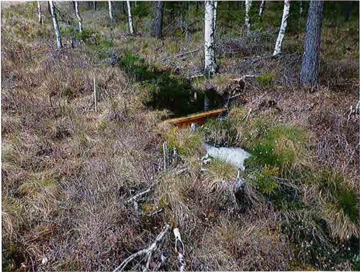
Figur 6. En dikespropp byggd av spontade 28 mm brädor i en utdikad våtmark. Denna typ av dikespropp är en billig lösning som kan användas i våtmarker där trädrötter och stenar saknas. De spontade brädorna som spetsas i nerändan slås ner med en slägga och binds ihop med en 45 * 45 mm regel i överkant varefter brädorna sågas av.
