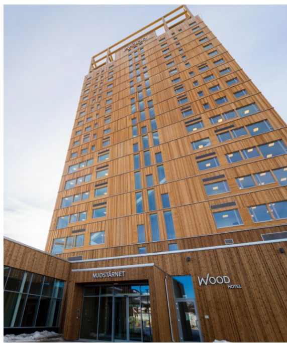
Projektets insatser har resulterat i ett ökat politiskt intresse där träbyggnation kommit upp på dagordningen hos flera kommuner.
